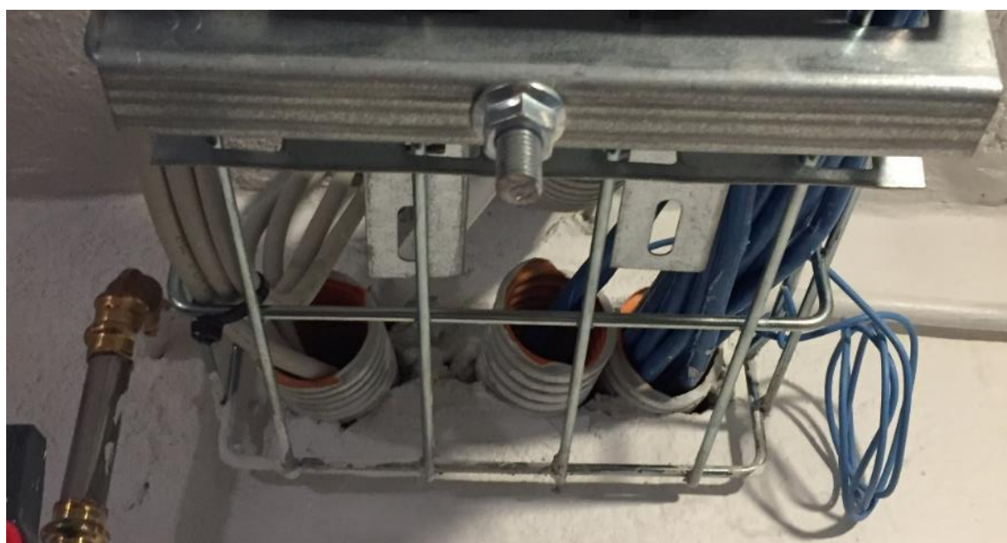
Figur 2: Manglende brandtætning ved installationsgennemføring i kælder
