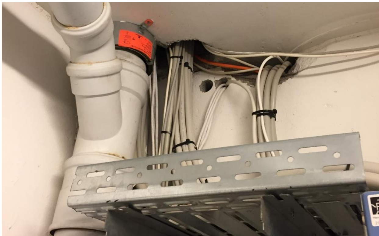
Figur 1: Manglende brandtætning ved elinstallationer i kælder.
